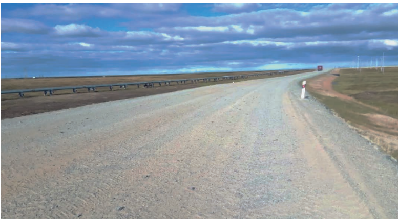
Рис. 3. Состояние покрытия в 2020 г., устроенного в 2018 г., на подъезде к кусту скважин № 12 ПОНМ с увеличенной нормой заклинивающей фракции и заполнением пор ДО песком
