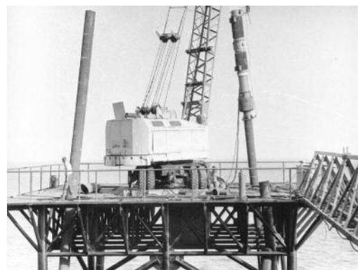
Рис. 3. Электромагнитный молот МЭМ30 на строительстве морской платформы в Черном море на газовом месторождении Галицыно-4 ПО «Черноморнефтегаз», 1982 г.
