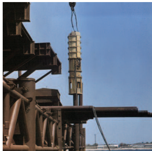
Рис. 4. Электромагнитный молот МЭМ100 на строительстве морской эстакады ПО «Черноморнефтегаз», 1988 г.
