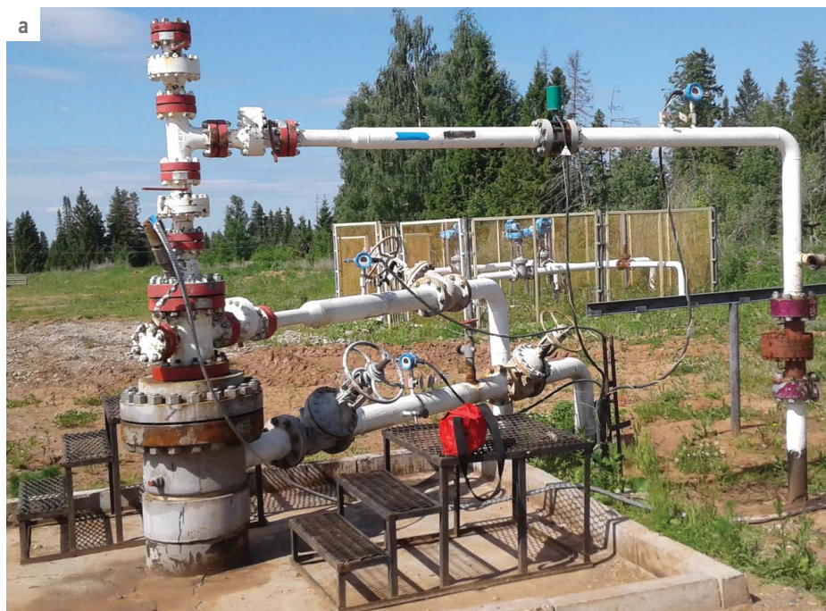
Рис. 2. а) внешний вид шурфовой установки раннего сброса попутно добываемой воды на месторождении X; б) схема установки: 1 — колонная головка ( D = 508 мм); 2 — цементная стяжка; 3 — эксплуатационная колонна ( D = 324 \times 9,5 мм, L = 5 м); 4 — цементный камень; 5 — подвесной патрубок; НКТ ( D = 73 \times 5,5 мм, L = 10 м); 6 — труба обсадная ( D = 508 \times 11,1 мм, L = 52 м); 7 — цементный камень; 8 — УЭЦН ( L = 40 м, ПЭД в кожухе); 9 — цементный стакан; 10 — шахтное направление. Составлено авторами Fig. 2. а) the appearance of the sump well for the early discharge of associated water at field X; б) sump well scheme: 1 — casing head ( D = 508 мм); 2 — cement screed; 3 — production casing ( D = 324 \times 9,5 мм, L = 5 м); 4 — cement stone; 5 — tubing hanger; tubing ( D = 73 \times 5,5 мм, L = 10 м); 6 — casing pipe ( D = 508 \times 11,1 мм, L = 52 м); 7 — cement stone; 8 — electrical submersible pump unit ( L = 40 м, downhole motor); 9 — cement cup; 10 — conductor casing. Prepared by the authors
