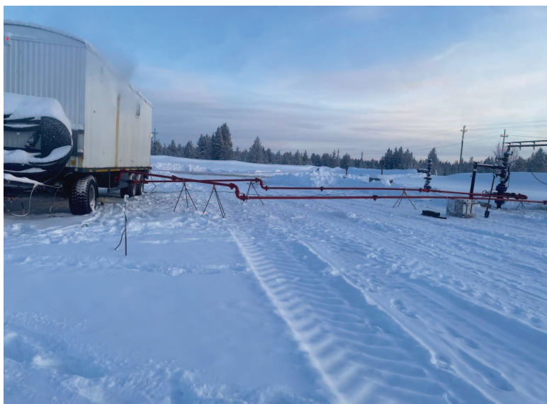
Рис. 2. Работа КУДР-33 по закачке реагентов на скважине. Составлено авторами Fig. 2. Operation of the reagent injection unit at the well. Prepared by the authors
